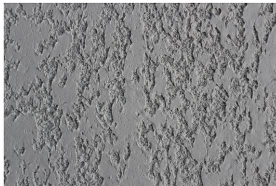
Через 10-30 минут (в зависимости от температуры окружающей среды и влажности воздуха в помещении) при помощи шпателя или гладилки выравнивается поверхностный слой нанесенных капель. Давление рукой на шпатель или гладилку несильное, лезвие шпателя или полотно гладилки под 45 градусов.
